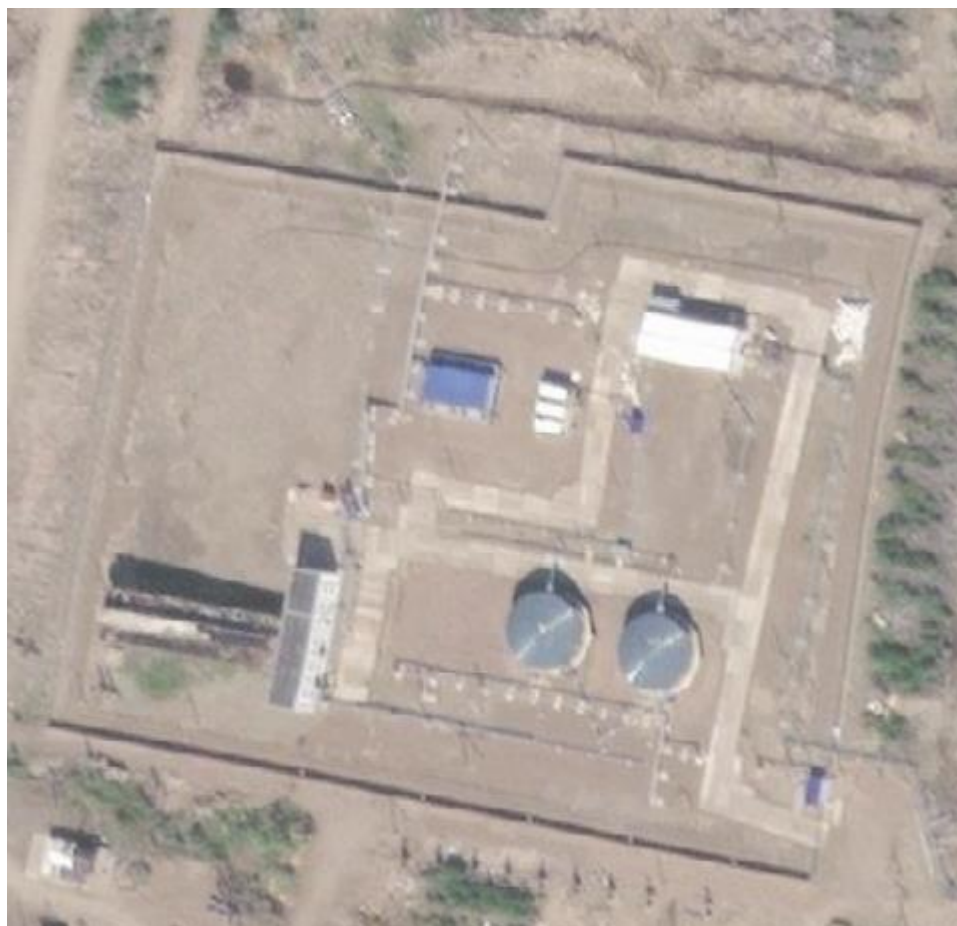
Рисунок 1- Водозаборное сооружения «КЕССОН», г. Игарка.
