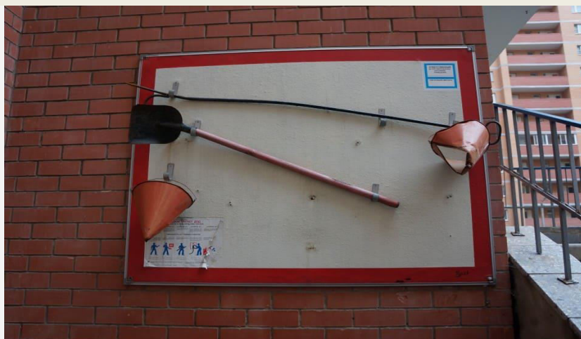
Современный пожарный щит с пожарными ведрами
